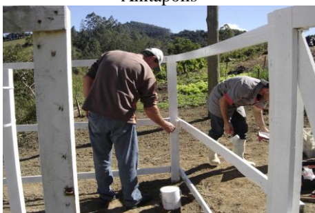
Pintura do cercado da estação Santa Rosa de Lima
