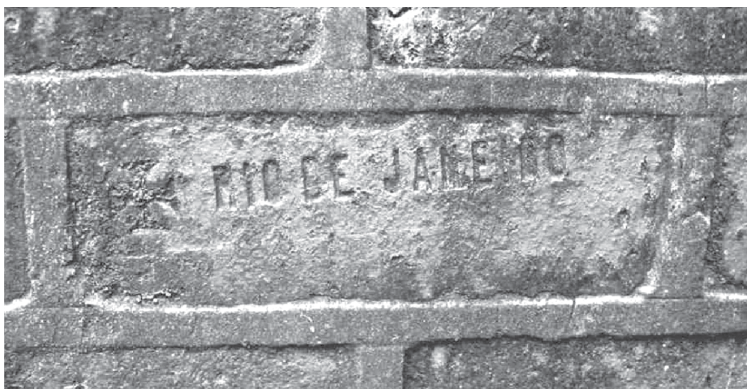
Figura 1: Tijolo proveniente do Rio de Janeiro no Tanque de Desinfecção da Barra, em Ouro Preto. Foto Alberto Fonseca, 2005
