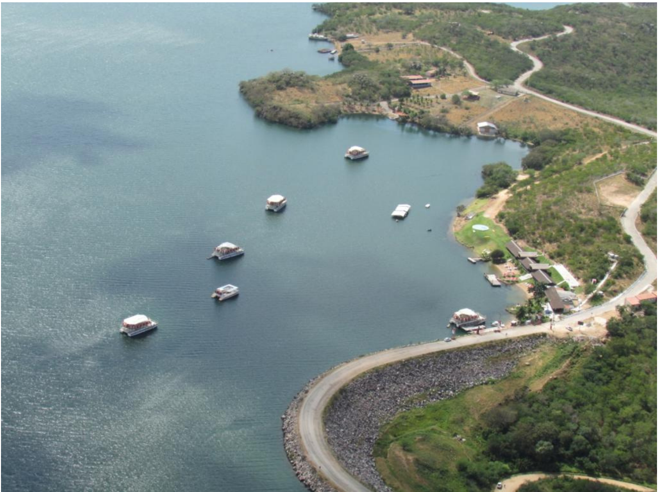
RESERVATÓRIO DE XINGÓ
