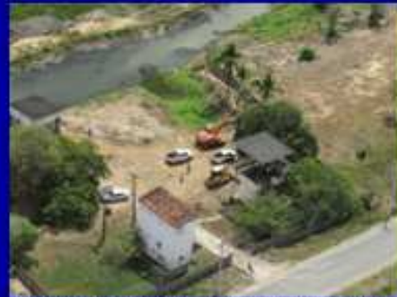
Captação DESO – abastecimento de Propriá/SE. Observam-se máquinas trabalhando
