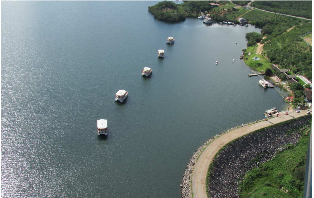
RESERVATÓRIO - UHE XINGÓ
